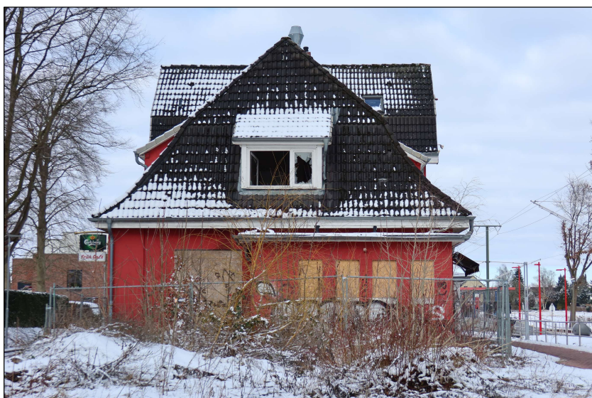
Abb. 6: Dach Alter Bahnhof in Hasloh (Manthey 15.02.2026)
