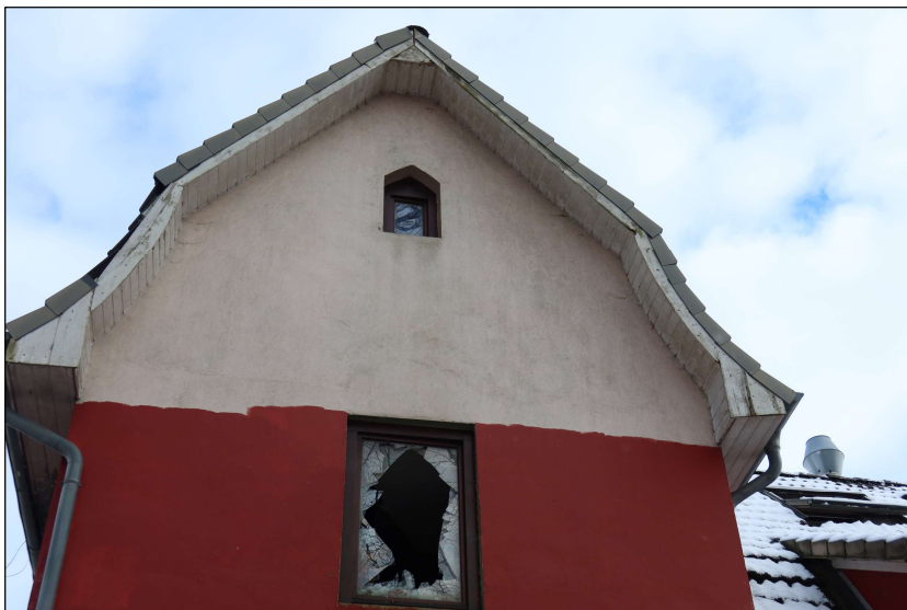
Abb. 4: Holzverschalung Nordseite Alter Bahnhof in Hasloh (Manthey 15.02.2026)
