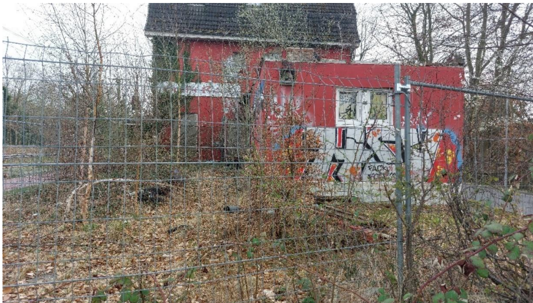
Abb. 5: Ruderalflur nördlich des Gebäudes
